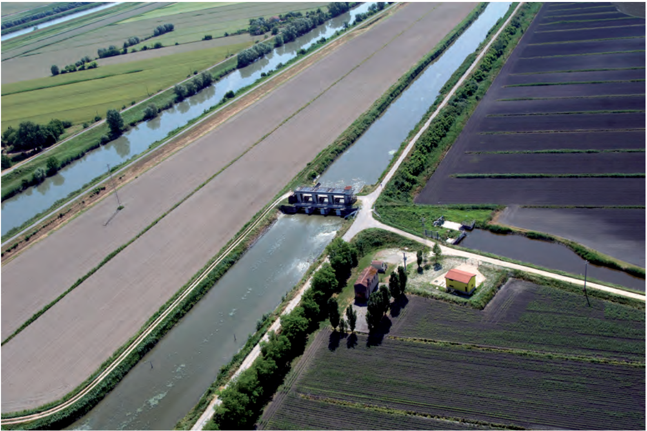
Figura 3.6: Barriera anti intrusione salina lungo il Canal Morto.
